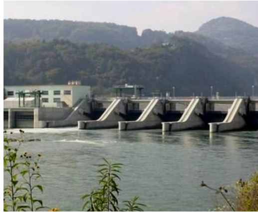
Hidroelektrarna Boštanj (Sava)
