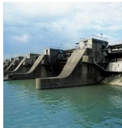
Hidroelektrarna Zlatoličje (Drava)
