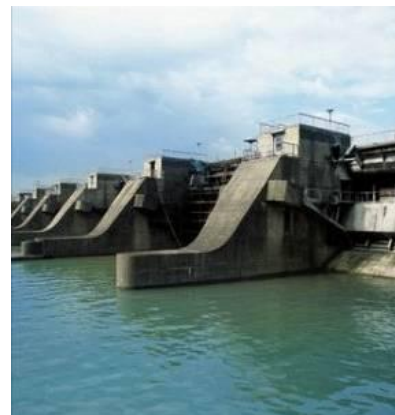
Hidroelektrarna Zlatoličje (Drava)
